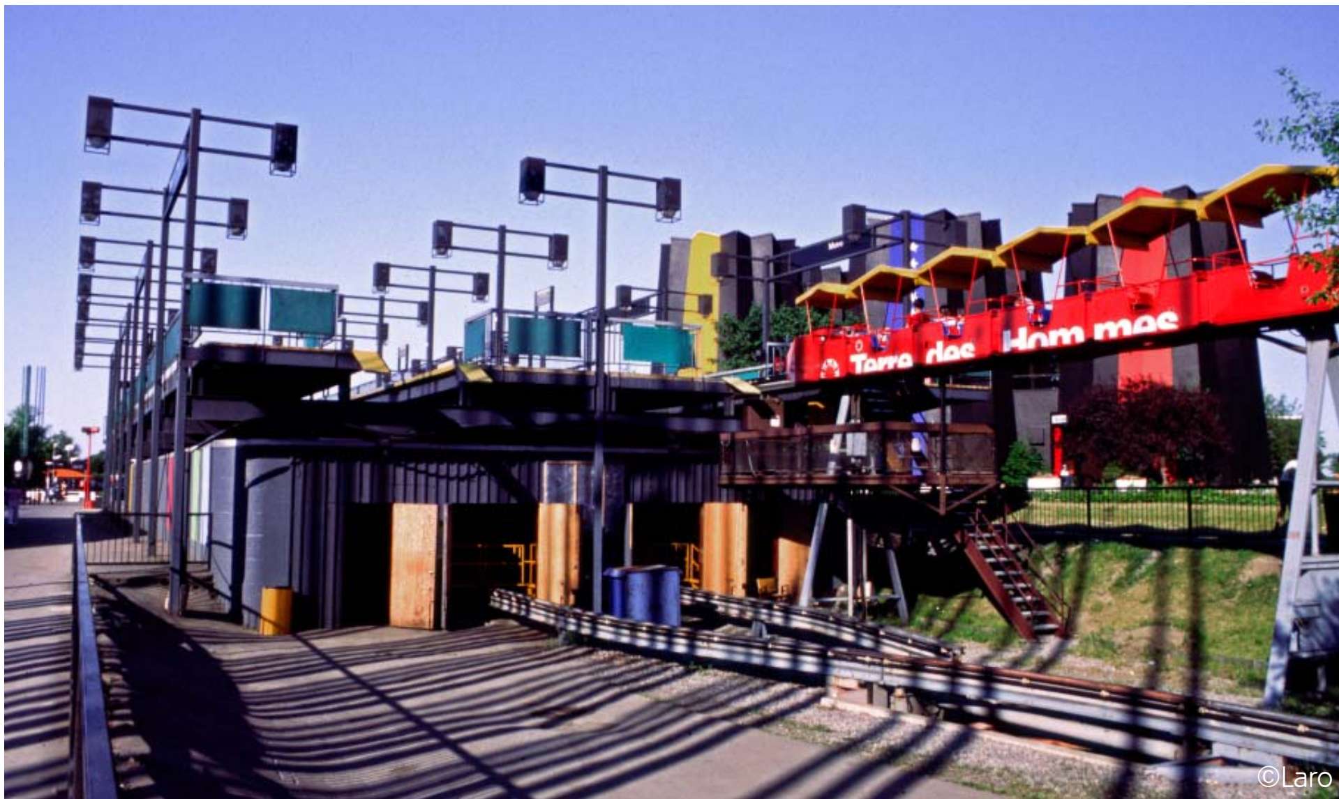
Station « Métro » - Suite à la démolition du circuit de l'île Notre-Dame, cette station ne servait que pour le minirail de l'île Ste-Hélène – La voie du second réseau de minirail a été enlevée.
