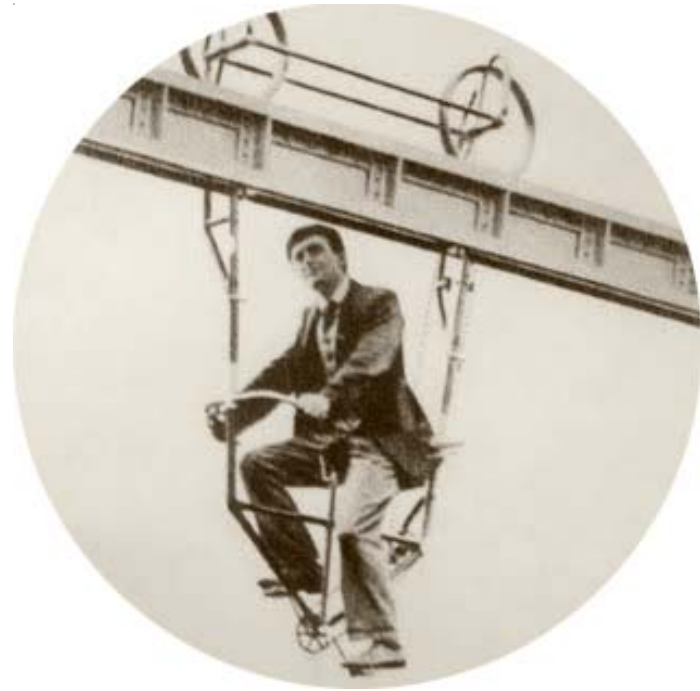
Ancêtre du monorail: le « Hotchkiss Bicycle Railway » , construit par Arthur E Hotchkiss en 1892 qui circulait entre Mount Holly et Smithville, au New Jersey.
